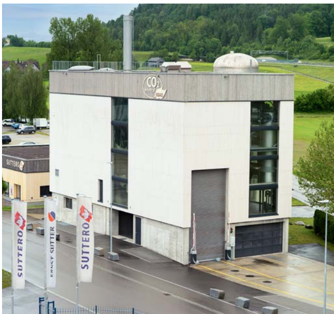
Construit en collaboration avec Schlachtbetrieb St. Gallen AG, le système de chauffage aux copeaux de bois permet d'économiser près de 3000 tonnes de CO 2 par an.
