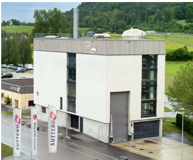
Die in Zusammenarbeit mit der Schlachtbetrieb St.Gallen AG erbaute Holzschmelzeheizung spart jährlich rund 3000 Tonnen CO 2 -Emissionen ein.
